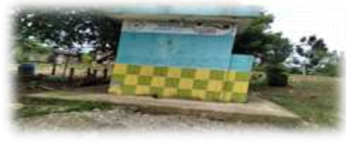
Batería Sanitaria Recinto Estero Torres
